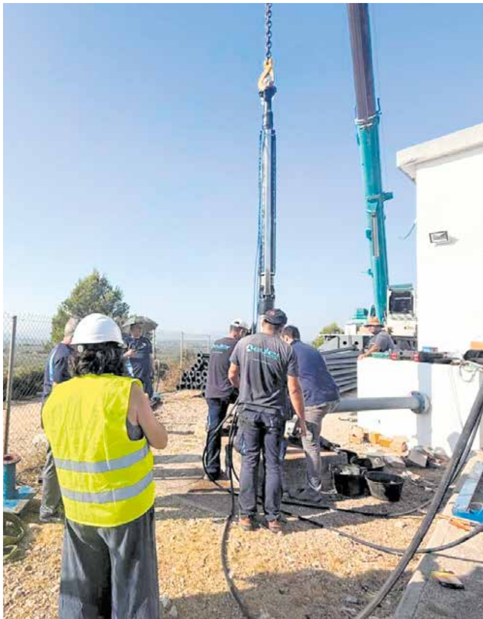
Operaris, durant els treballs d'urgència al pou Barrisques. / EPDA
