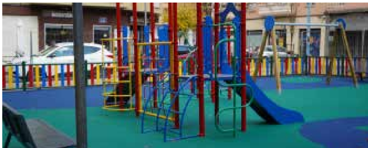
Alguns dels parcs infantils que han sigut renovats amb paviments de seguretat i nous elements de joc. / EPDA
