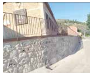
Nuevo talud. / EPDA
