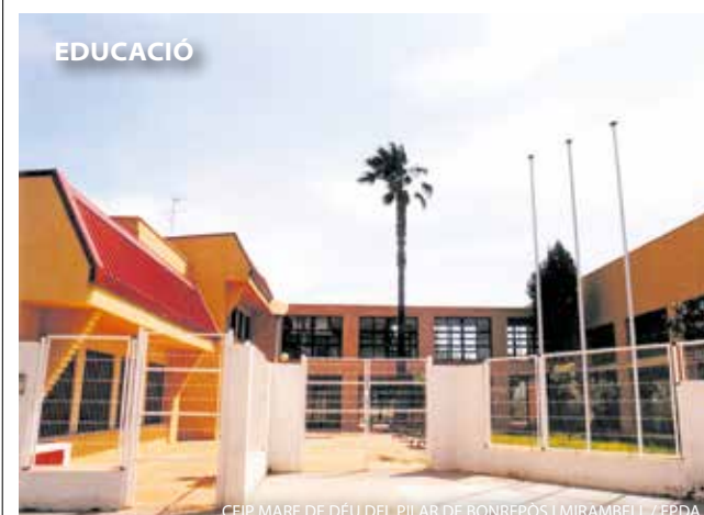
CEIP MARE DE DÉU DEL PILAR DE BONREPÒS I MIRAMBELL. / EPDA
