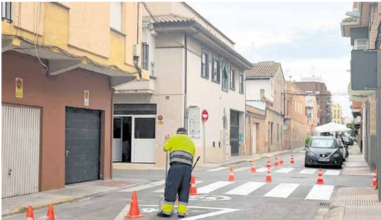
Un operari municipal repintant un pas de vianants pròxim a una zona escolar d'Alfafar. / EPDA
