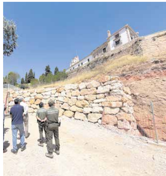
Visita a las obras del Santuario del Remedio. / EPDA
