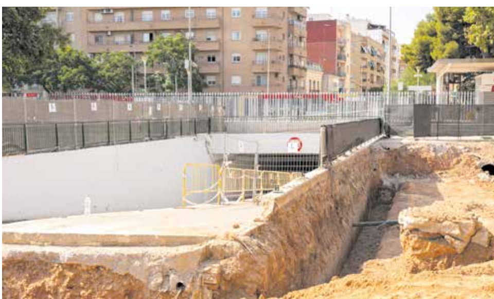
Treballs corresponents a les obres d'emergència al barranc de la Saleta. / JAIME SORIANO
