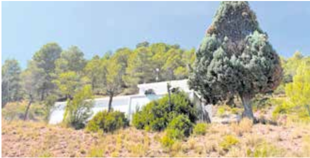
El depósito de agua de Montanejos. / EPDA
