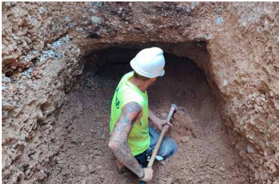
Refugi antiaeri localitzat durant les obres al centre de l'Eliana. / EPDA
