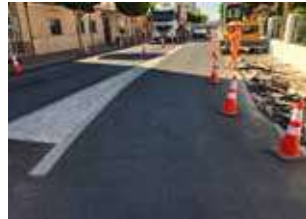
Obras en la travesía. / EPDA
