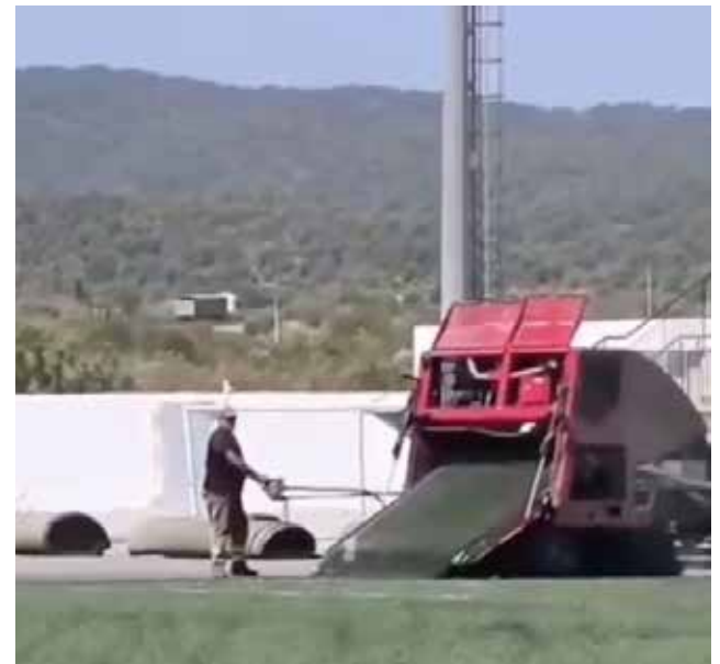
Treballs de renovació al camp de futbol. / EPDA
