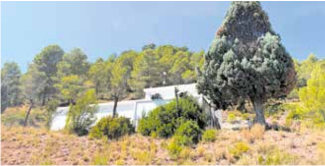
El depósito de agua de Montanejos. / EPDA
