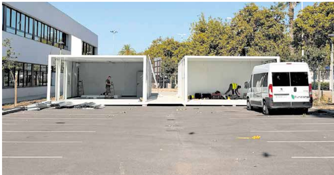
La instalación de aulas prefabricadas en el IES Altos Hornos del Port de Sagunt. / EPDA
