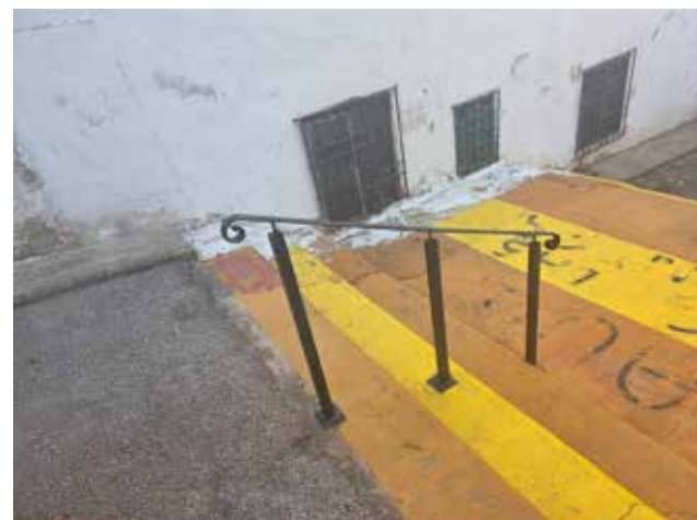
Nuevas barandillas en la calle Peñas. / EPDA
