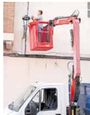
Treballs d'instal·lació. / EPDA
