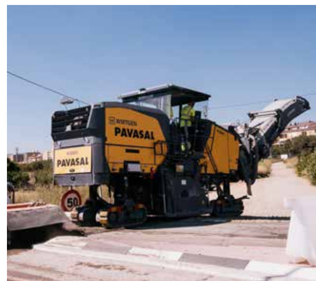
Maquinaria durante las obras de renovación. / EPDA
