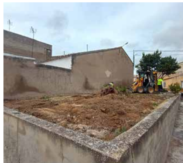
Trabajos de renovación de jardines. / EPDA
