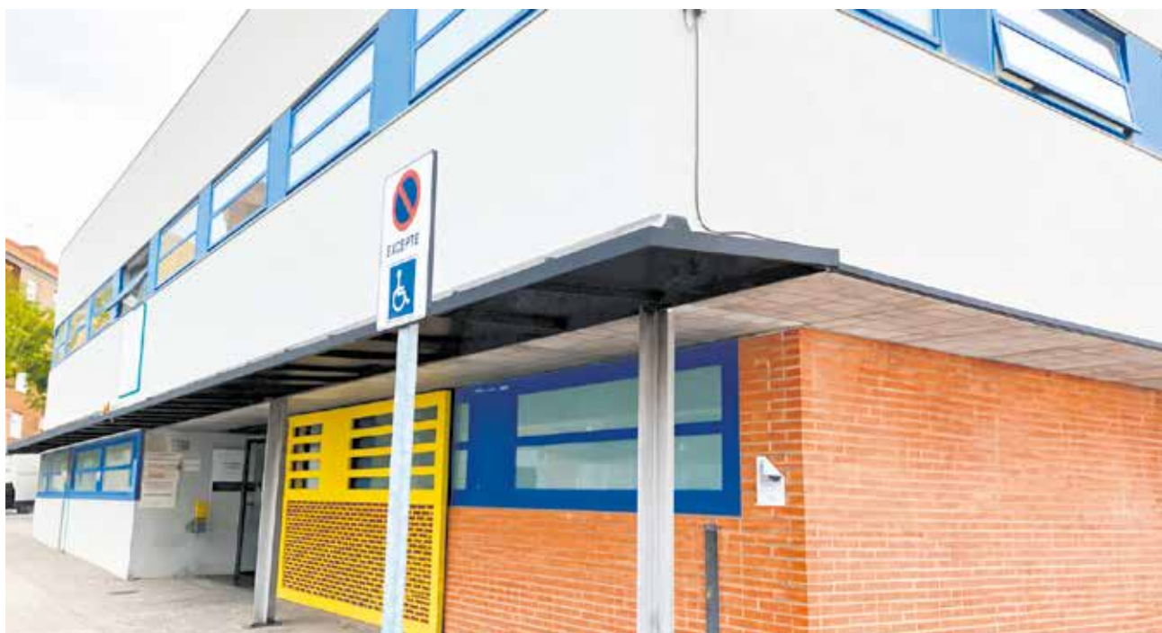
Aspecte actual del centre de salut d'Aldaia. / EPDA
