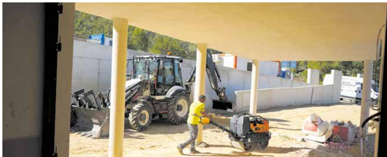
Les obres del Centre de Dia per a persones amb diversitat funcional avancen a bon ritme. / EPDA
