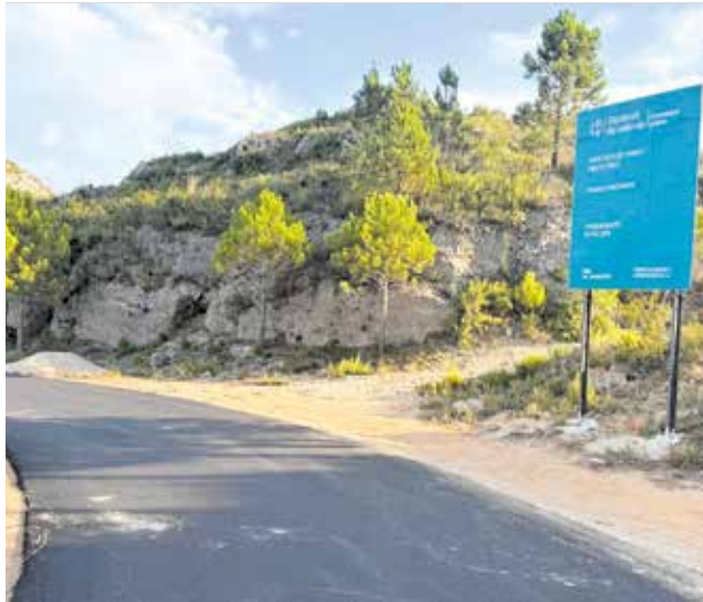
Asfaltatge dels camins cap a Pla de Coralls i Barx. / EPDA
