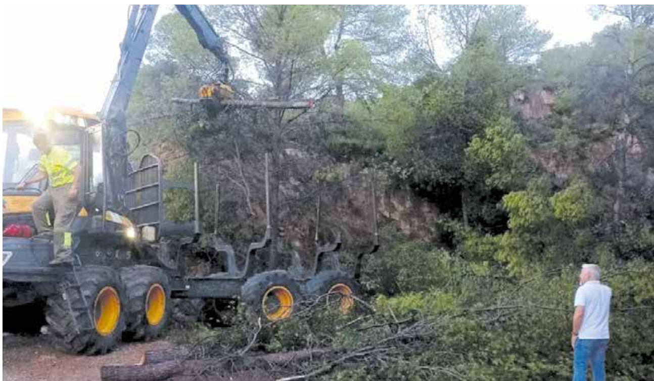
Trabajos de prevención de incendios forestales en el término municipal de Náquera. / EPDA
