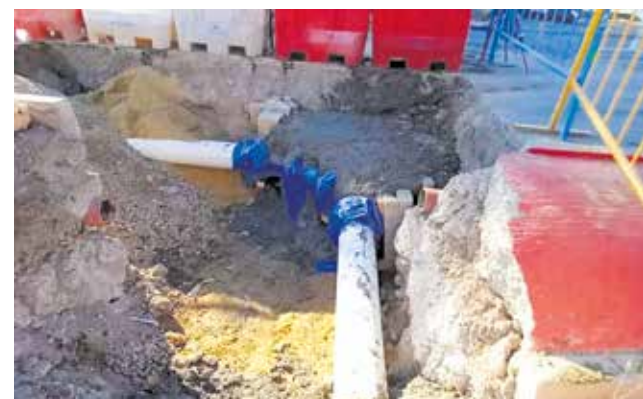
Obras de la nueva tubería de Náquera. / EPDA
