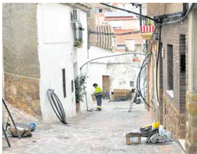
Un operari en els treballs del carrer La Pobleta. / EPDA
