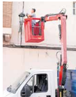
Treballs d'instal·lació. / EPDA
