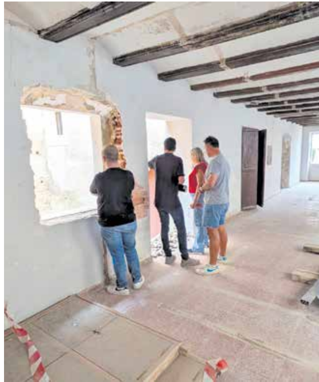
Visita a las obras de la Casa Grande de Altura. / AYUNTAMIENTO DE ALTURA
