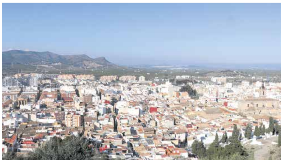
Vista aèria de Sagunt. / EPDA
