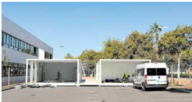
Instal·lació d'aules prefabricades a Sagunt. / EPDA
