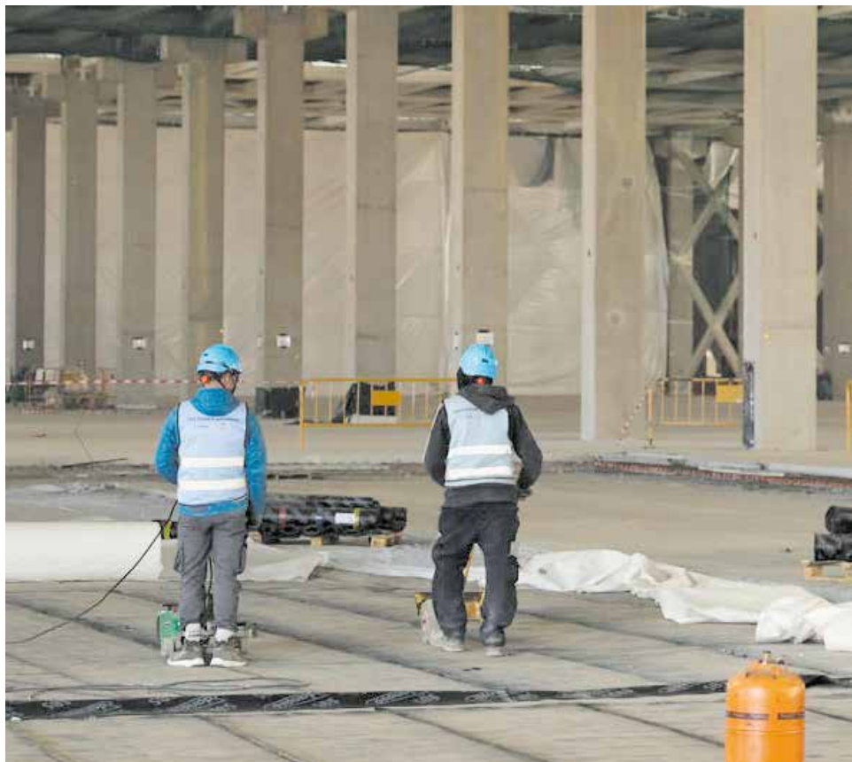
Dos operaris en una de les naus de PowerCo a Sagunt. / EPDA
