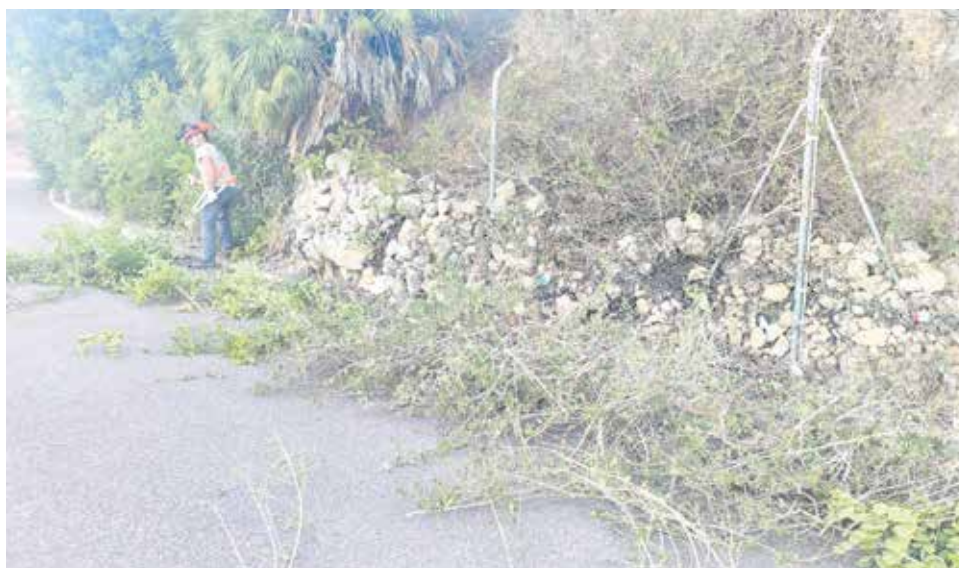
Canal interceptador (dalt) i obres en la Muntanya Assolada (baix), ja finalitzades. / EPDA
