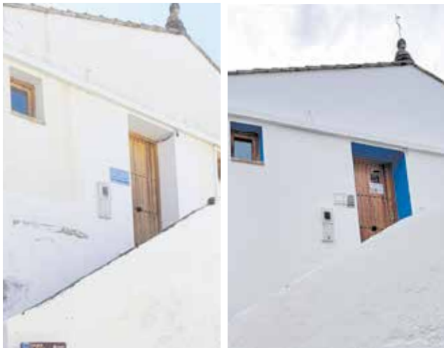
Antes y después de la biblioteca municipal. / EPDA
