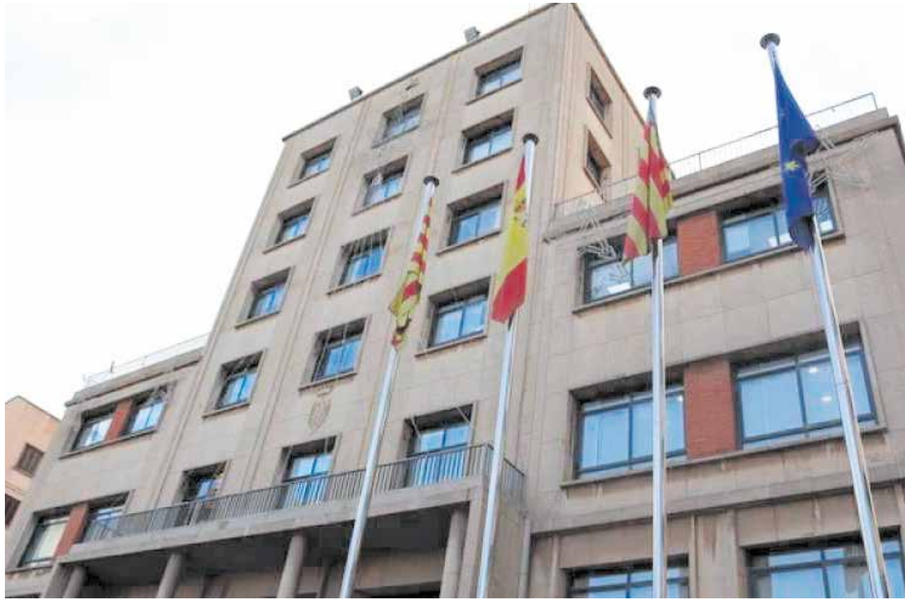
Façana de l'Ajuntament de Vila-real. / AJUNTAMENT DE VILA-REAL
