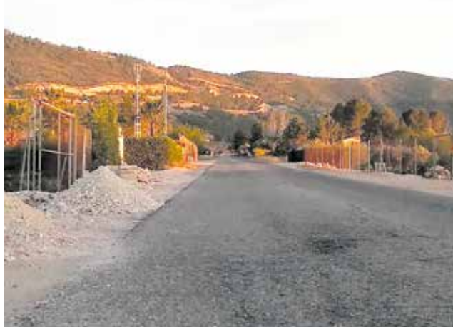
L'antiga carretera de Canals a l'Olleria. / EPDA
