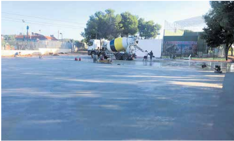
Los trabajos de hormigonado de la pista polivalente. / EPDA
