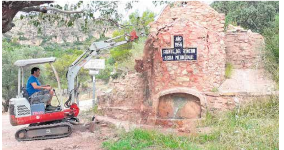
Trabajos de rehabilitación en la Fuente del Rincón. / EPDA
