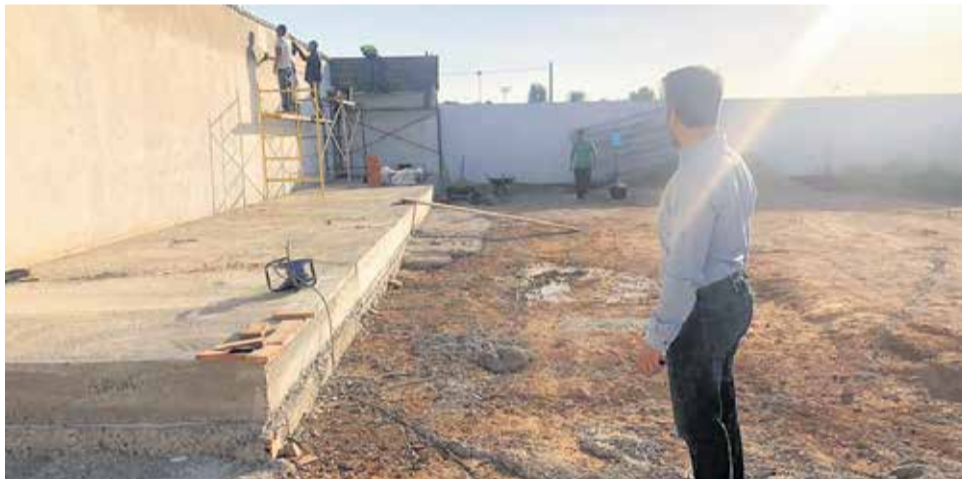
El alcalde visita el cementerio para ver la marcha de las obras. / EPDA
