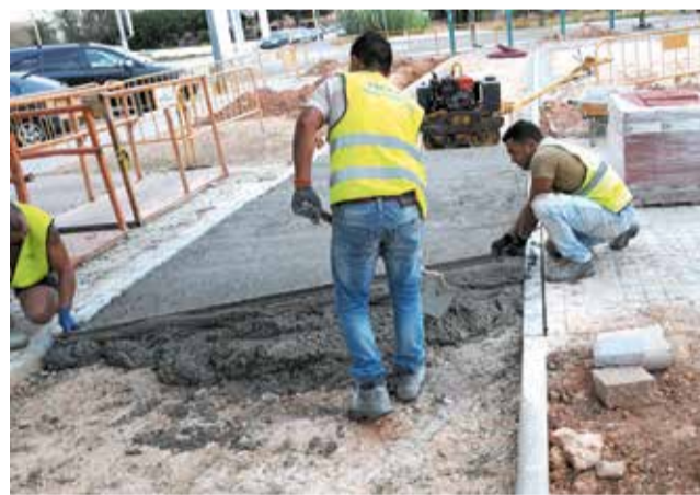
Obras del carril bici. / EPDA
