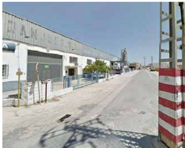
Polígono industrial de Beniparrell. / EPDA
