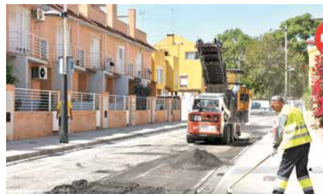
Obrero reasfaltando las calles del municipio. / EPDA
